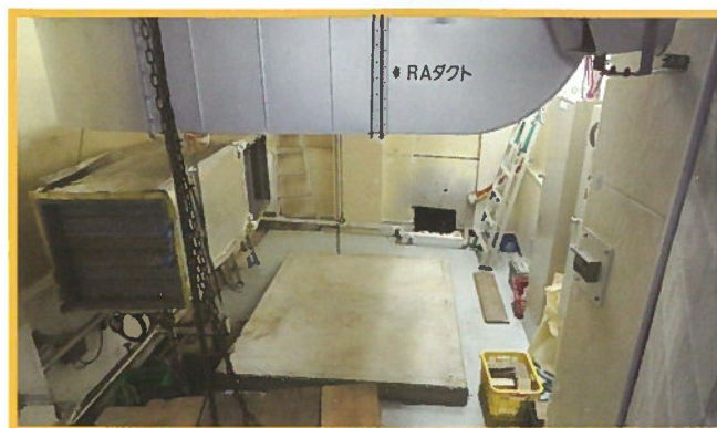
レクチャーホール機械室内既設機器撤去
