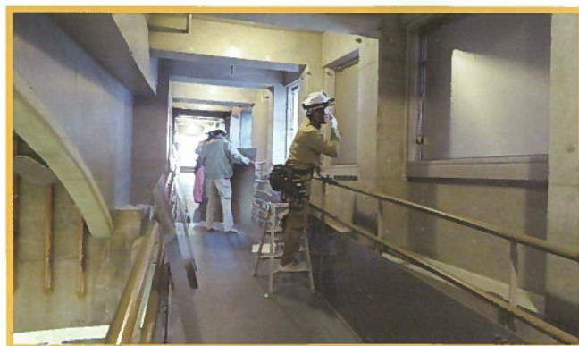
館内スロープ遮光板取り付け
