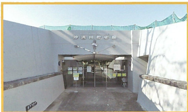
塗装が完了した正面入口の壁面
