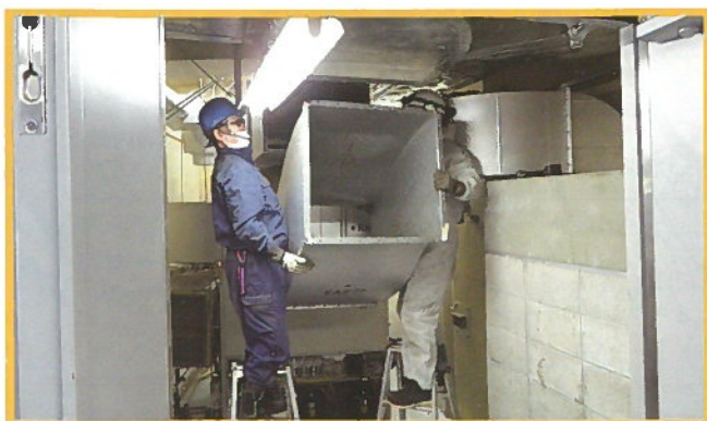
レクチャーホール機械室内既設機器取り外し作業
