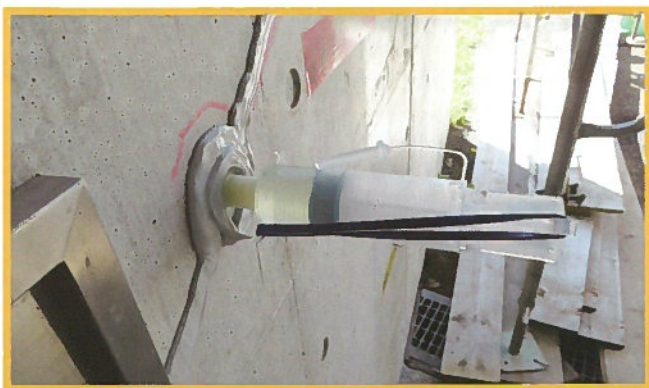
外壁補修樹脂注入
