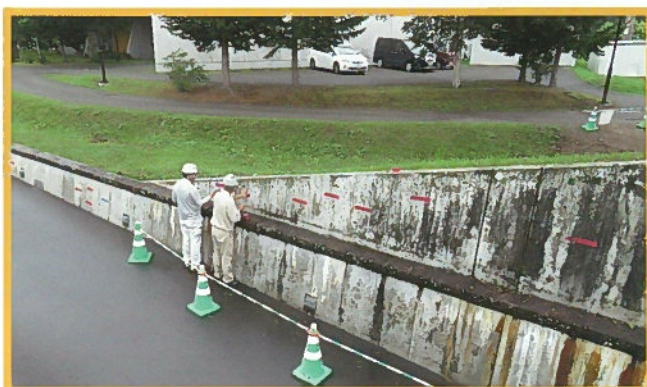
外壁調査の様子
