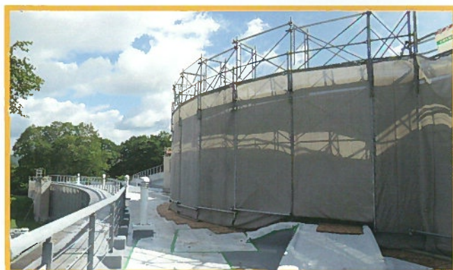
足場が組まれた展望ギャラリー
