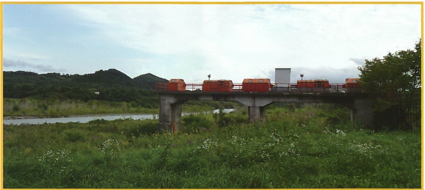
沙流頭首工（北西から）。二風谷ダムの完成にともないその役割を終え、現在は頭首工のみが保存されている。
