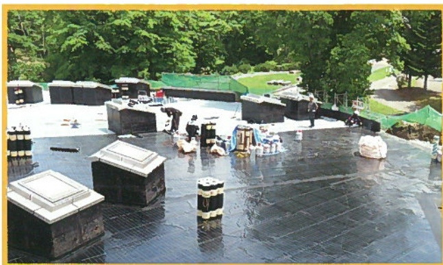
屋根上防水シート施工作業
