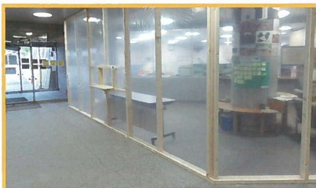
エントランスホール仮設事務室
