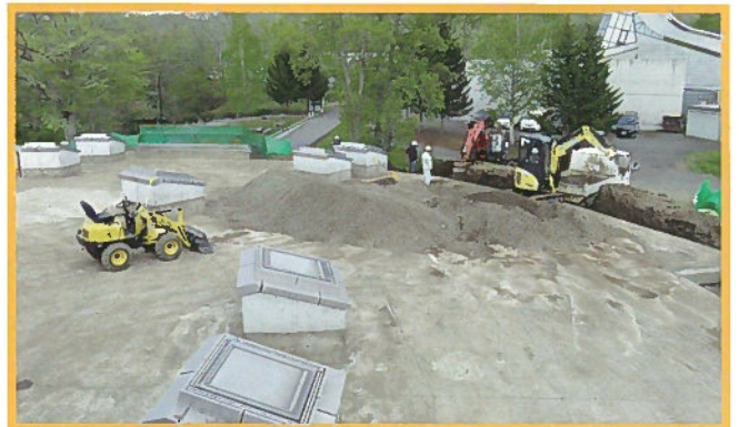
土壌・砂利撤去作業
