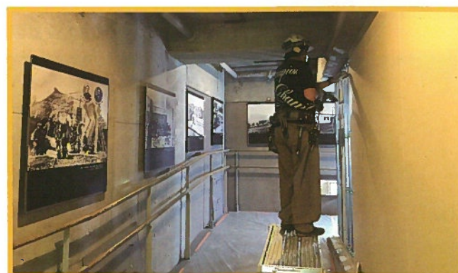
スロープ壁面設置
