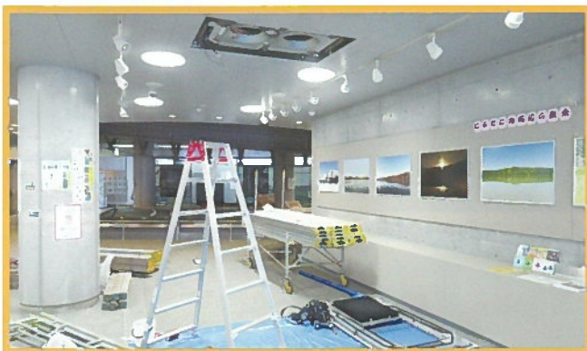
空調機器交換（エントランスホール）
