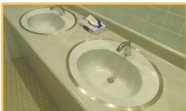
トイレ手洗場センサー式蛇口
