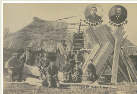
◀ 明治25(1892)年創立の二風谷小学校校舎 写真所蔵: 平取町
