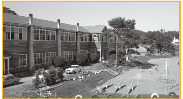
(写真1) 戦前に建てられた平取小学校の4代目校舎。昭和47(1972)年頃。国道237号線沿いにあった。現在は特別養護老人ホーム平取かつら園が所在する(この写真は開拓財産展示施設にてご覧いただけます)。
