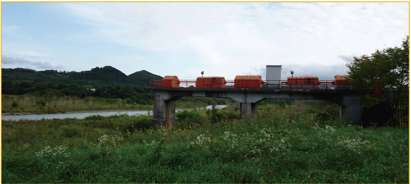
沙流頭首工(北西から)。二風谷ダムの完成に伴いその役割を終え、現在は頭首工のみが保存されている。
