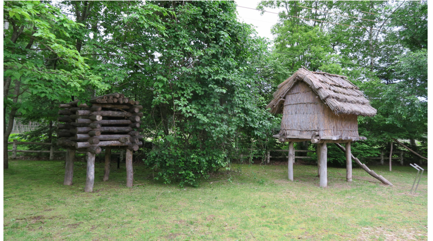
写真1 二風谷アイヌ文化博物館屋外展示のヘペレセツ(仔グマの寝床:写真左)とブ(高床式倉庫:写真右)。ヘペレセツはイヨマンテに関わる重要施設で、ブはネズミなどの小動物の侵入を防ぐために高床にし、普段ははしごを外していたと伝えられている。こうした施設に地域の動物との関係性や配慮をみることができる
